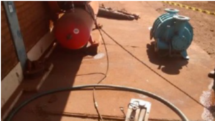
Figura 4: Execução do teste hidrostático
